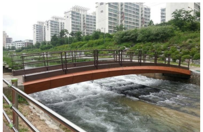
우이천 하천정비공사 중 우이천교 / 서울시도시기반시설본부 / L=22.0m, B=3.0m
